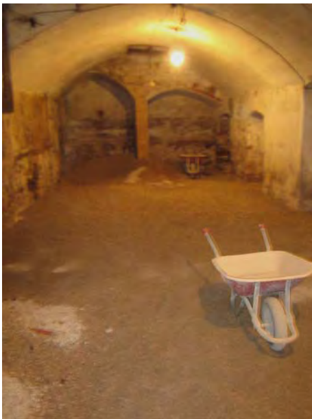
FOTO 41. Recobriments amb grava de les estructures de l'habitació 12
