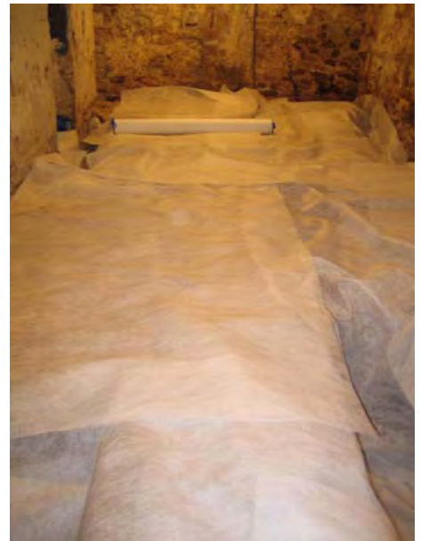
FOTO 34. Recobriment amb geotèxtil de les estructures de l'habitació 11
