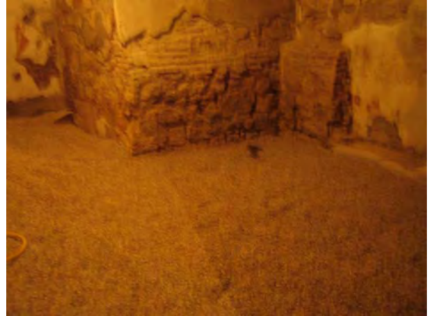
FOTO 40. Recobriments amb grava de les estructures de l'habitació 6
