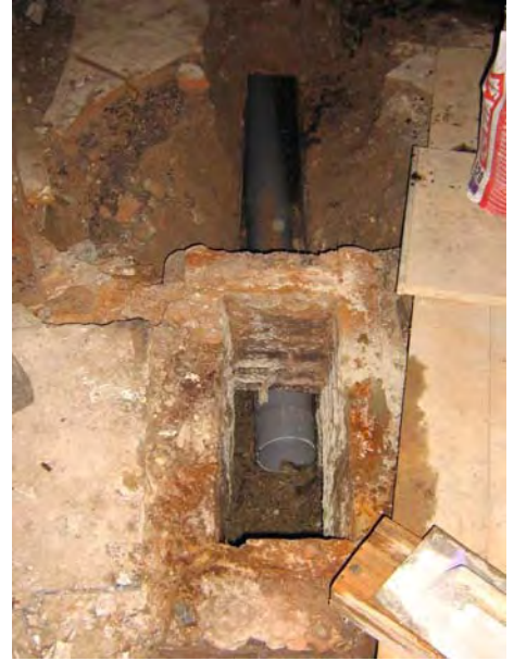
FOTO 32. Col·locació de tub de PVC a l'interior de la claveguera i l'arqueta descobertes
