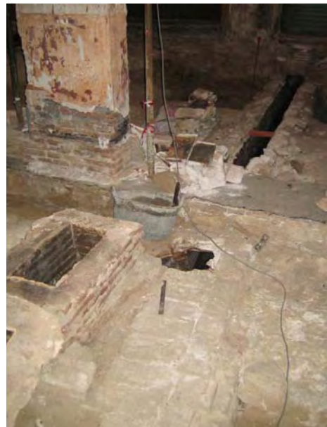
FOTO 26. Enretirada de la coberta de la claveguera i arqueta decimonòniques de les habitacions 9 i 10
