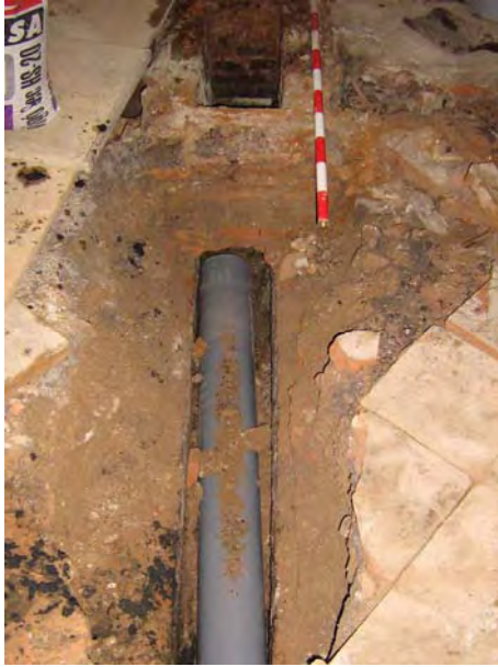
FOTO 31. Col·locació de tub de PVC a l'interior de la claveguera descoberta
