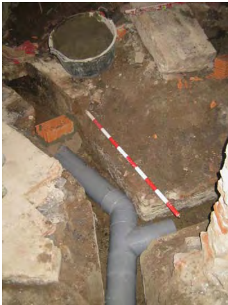
FOTO 33. Col·locació de tub de PVC a l'interior de la claveguera descoberta
