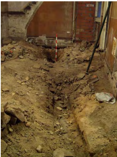
FOTO 25. Rasa per al nou clavegueram a l'habitació 4
